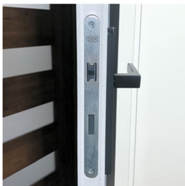
Zamek magnetyczny w skrzydle drzwiowym
